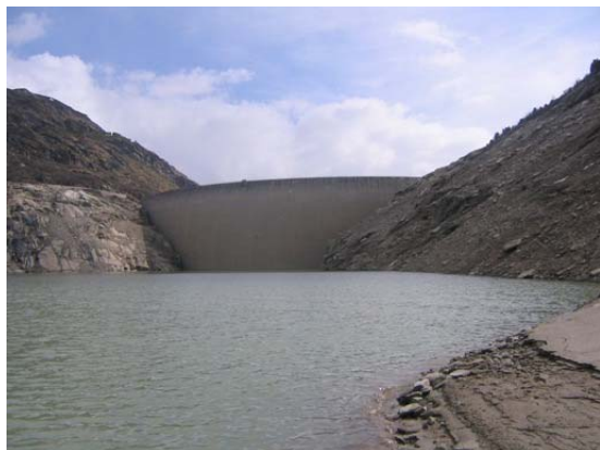
Zerrweila Stausee zur Stromproduktion in der Schweiz © Lucas Beck
